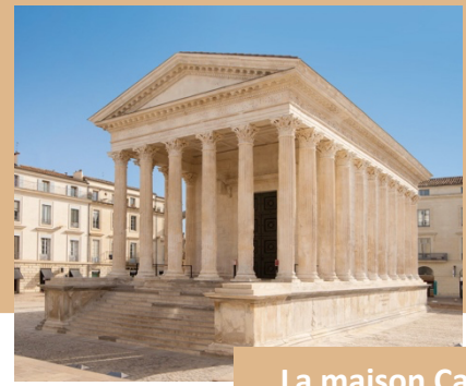
La maison Carrée
